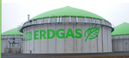
Die Bio-Erdgas-Anlage der Gasag in Schwedt
